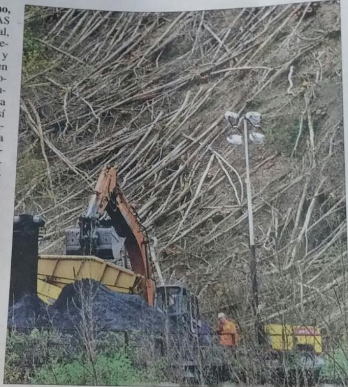
Trabajos de corta de masa forestal en la escombrera que Hunosa tiene en Figaredo. | FERNANDO GELJO
