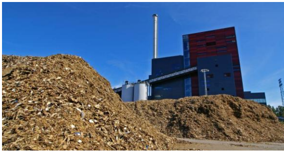
Planta de biomasa generada con restos madereros
