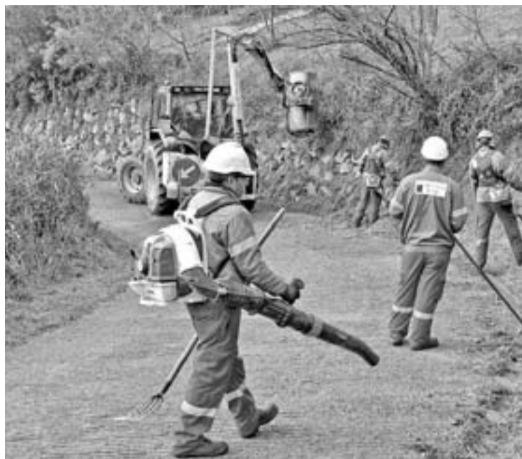
Operarios de una empresa forestal realizando labores de limpieza de cunetas. A la derecha, un tractor con desbrozadora de brazo limpiando el talud de un camino. | PABLO SOLARES
